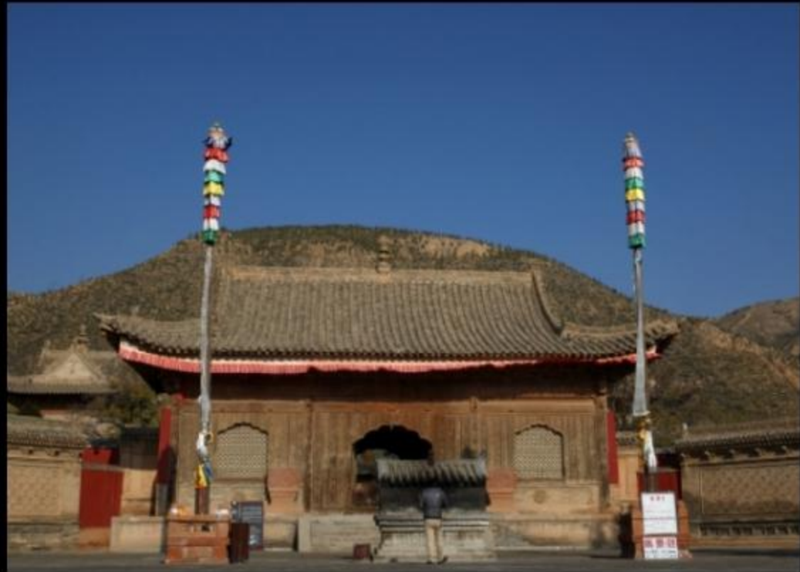
Rund 70 km südöstlich von Xining liegt das 600 Jahre alte Qutan Kloster, welches noch komplett aus Holz erbaut wurde und die älteste erhaltene Klosteranlage in der tibetischen Amdo Region ist.
